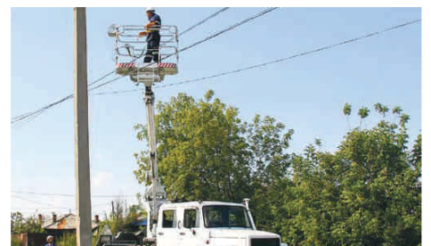
Реконструкция воздушной линии ВЛ 10 кВ от подстанции ПС 35/10 кВ «Рабочий посёлок»
