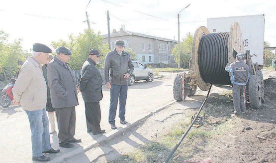
Реконструкция кабельной линии 10 кВ в микрорайоне «Береке»
