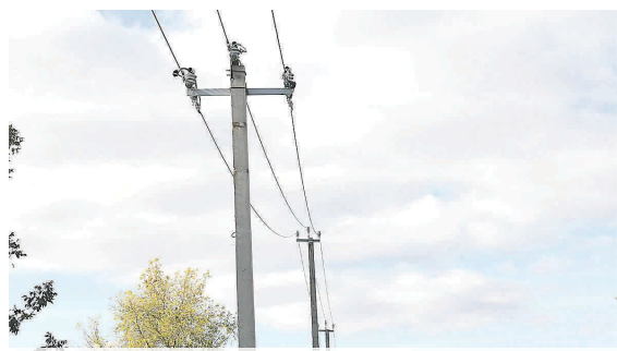
Воздушная линия 10 кВ фидер №17 от подстанции 110/10 кВ №1, выполненная с применением технологии СИП 3
