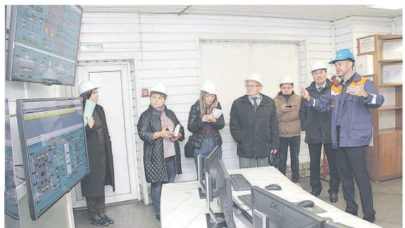
На щите управления в котельном цехе станции
