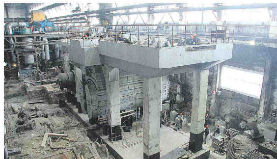
Монтаж турбоагрегата №5, февраль 2016 года
