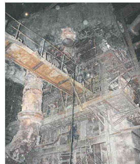
Реконструкция котлоагрегата №12, февраль 2015 года
