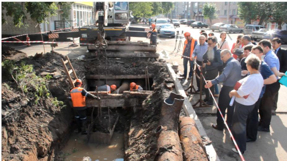
какие участки трубопровода подлежат замене, сети подвергаются гидравлическим испытаниям на прочность и плотность трубопроводов. По выявленным повреждениям на участках трубопровода производятся ремонты. Благодаря такой подготовке в отопительном сезоне 2017-2018 годов количество технологических нарушений снизилось на 12,3 % (с 220 до 193 случаев). Процент износа тепловых сетей на сегодняшний день составляет 65,1 %.
