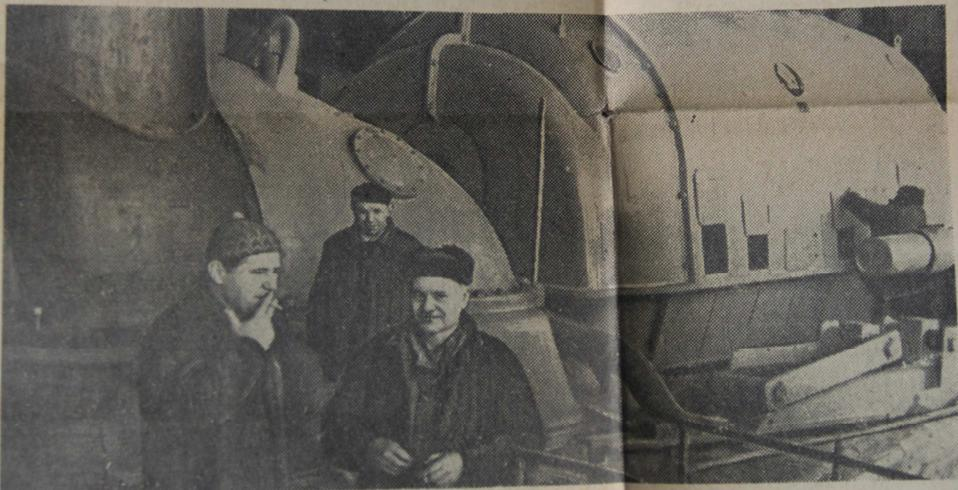
С опережением графика идет монтаж турбины № 5. На днях слесари бригады Ф. Гольбина успешно установили на фундаменте 70-тонный статор.
